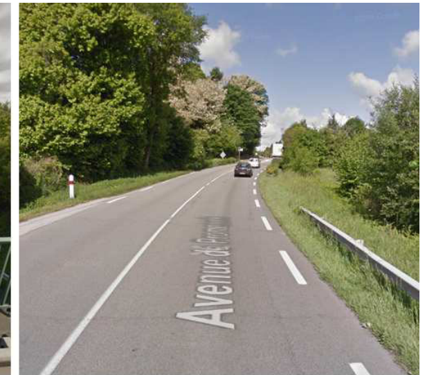
La RN145, à l'entrée de Saint-Sornin-Leulac
