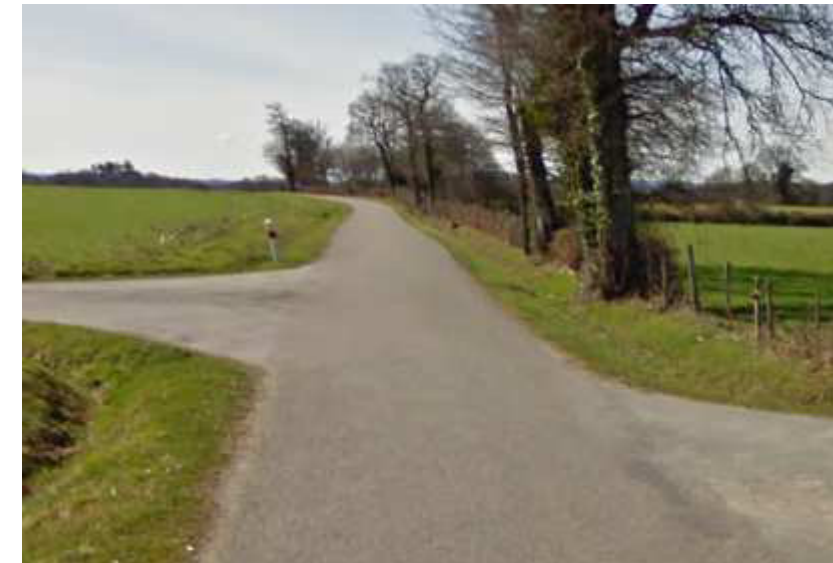
Illustration 61 : La RD93 entre Saint-Sornin-Leulac et Villemachoix, au niveau d'une intersection avec des voies communales (source : google street view)
